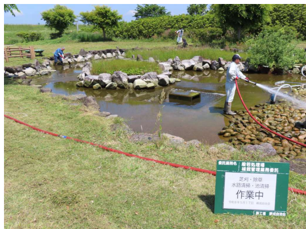
5月17日（日）、般若アクアセンター（下水処理施設）の、池掃除と除草を行いました。
